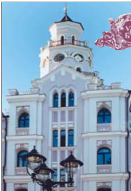
Корпус №3 УАБС НБУ.
